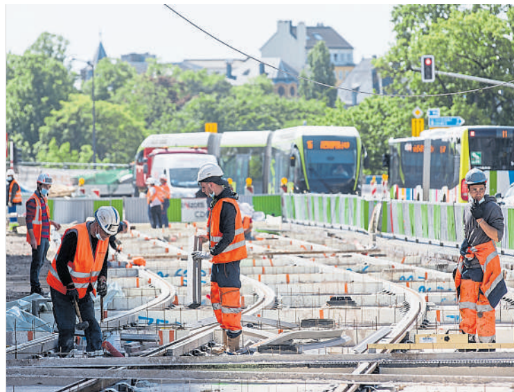
Sicherheitsabstand einhalten: die Trambaustelle in der Luxemburger Innenstadt.
